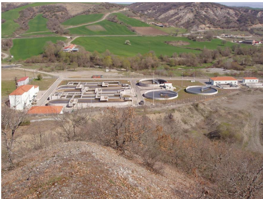
Εικόνα 18: Εγκαταστάσεις επεξεργασίας λυμάτων Γρεβενών
